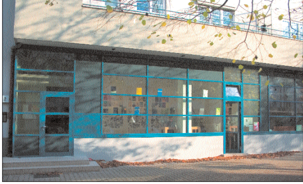
□ Geschäftsstelle DWB Hessen , in der Siedlung Bornheimer Hang in Frankfurt am Main entstanden 1925–30 unter dem Stadtbaurat Ernst May und Mitwirkung von Ferdinand Kramer, DWB Hessen
