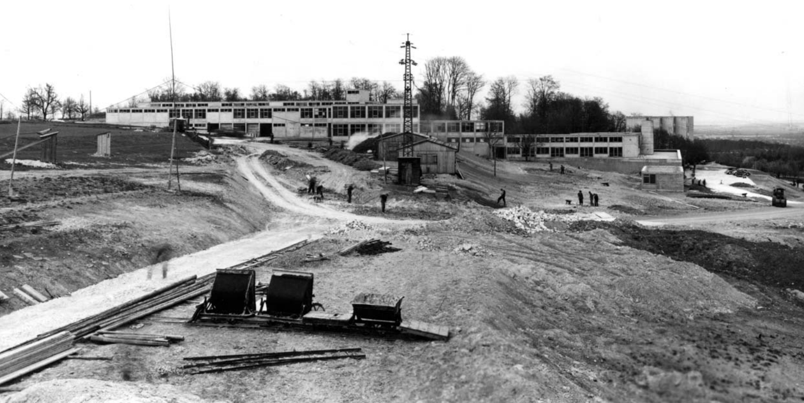
Baustelle der hfg ulm, Foto: Sisi von Schweinitz, 1954
