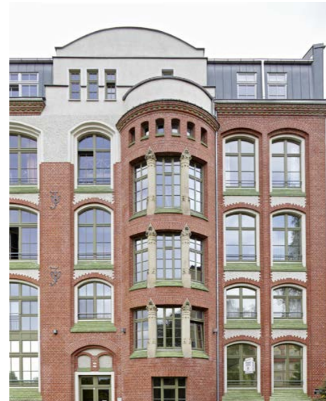
Büro- und Geschäftshaus ehem. Strumpfwirkerei William Janssen, Chemnitz
