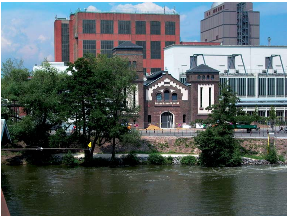
Blick auf das Druckwasserwerk von der Rhein-Neckar-Eisenbahnbrücke, Foto: Privat
