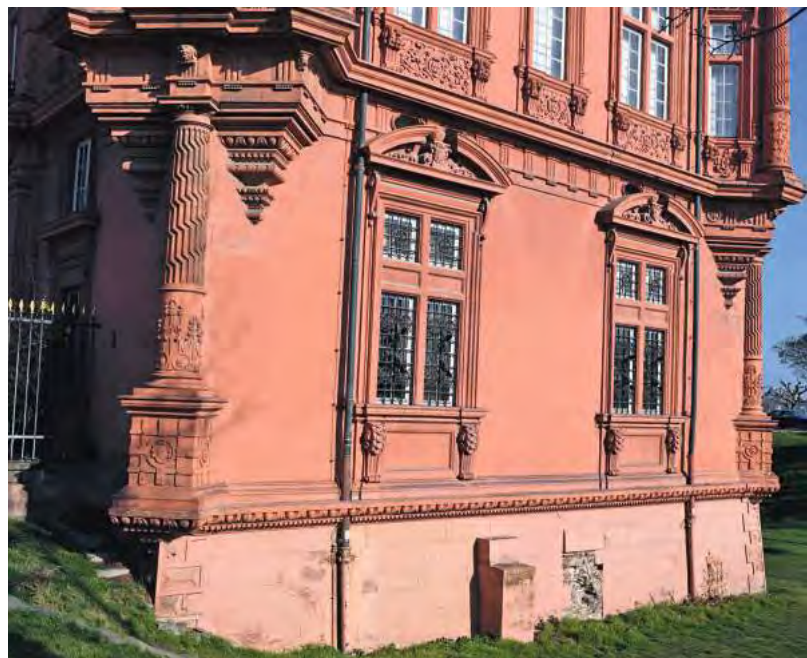
Abb. 37 Kurfürstliches Schloss, Kopfbau des Rheinflügels, Maueransatz des Übergangs zur ehem. Hofkanzlei.
