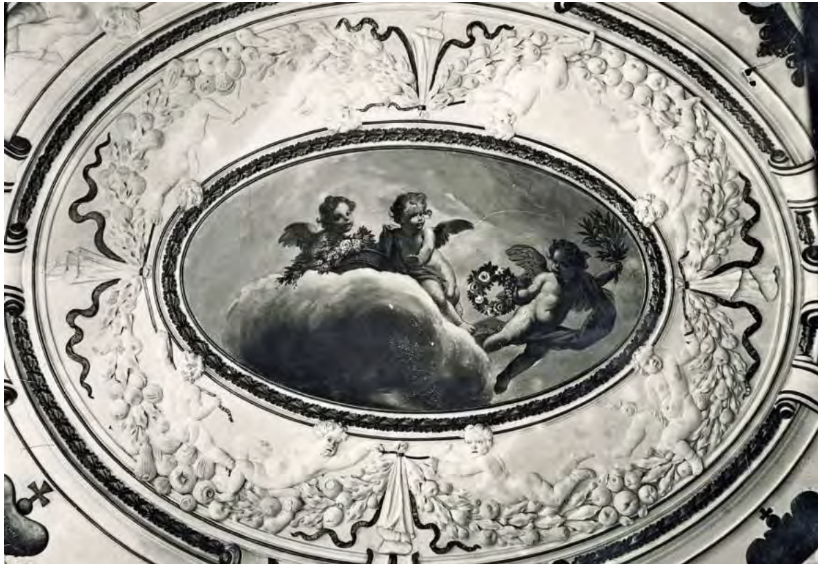
Abb. 49 Kurfürstliches Schloss, Rheinflügel, Stuckdecke im ehem. Spiegelzimmer mit wiederhergestellter Malerei.
