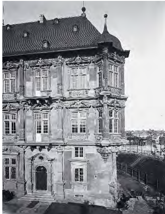
Abb. 36 Kurfürstliches Schloss, Rheinflügel, Hofseite mit erneuertem Portal und „regularisiertem“ Fenster.
