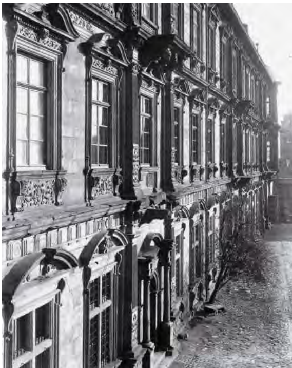
Abb. 7 Hoffassade des Rheinflügels vor Restaurierung.
