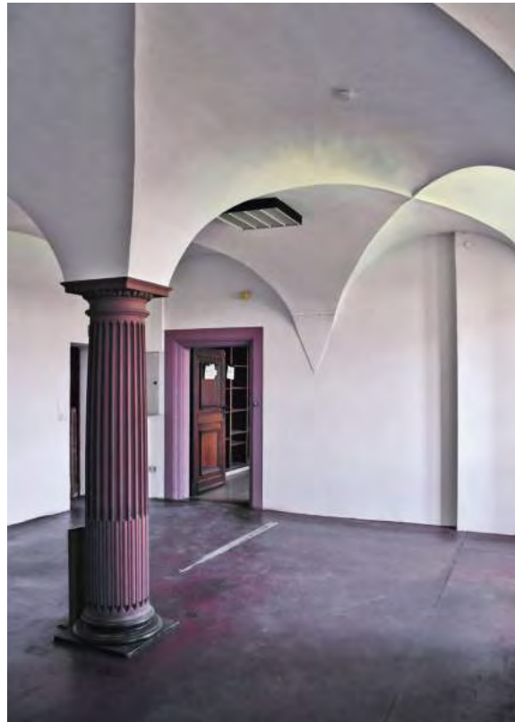
Abb. 43 Kurfürstliches Schloss, Rheinflügel, gewölbter Raum im Erdgeschoss.
